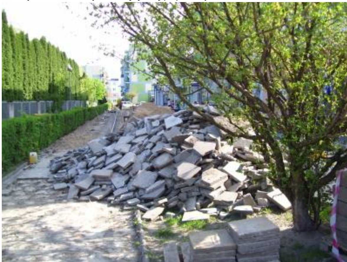
Przebudowa chodnika przy ulicy Ks. Zielińskiego, rok 2013
