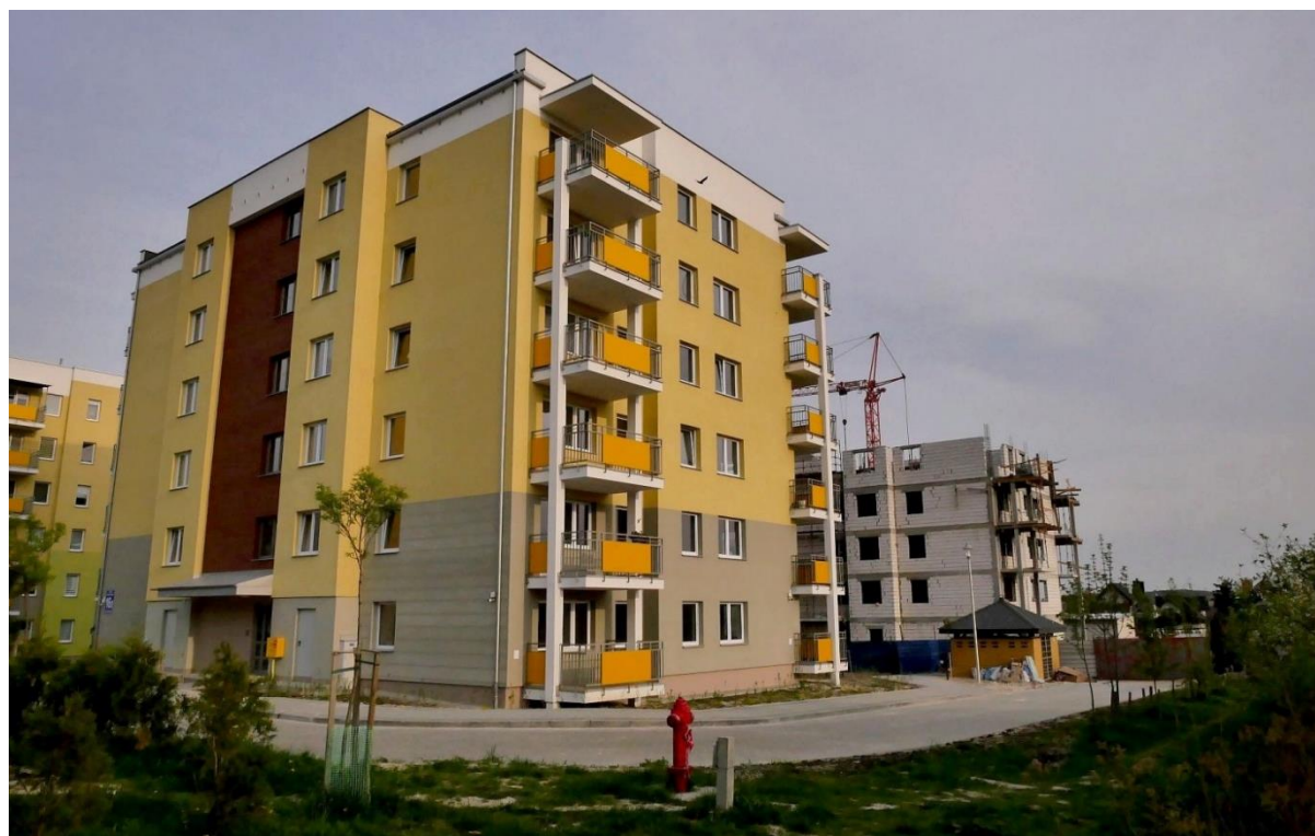
Budowa osiedla „Widok I”
