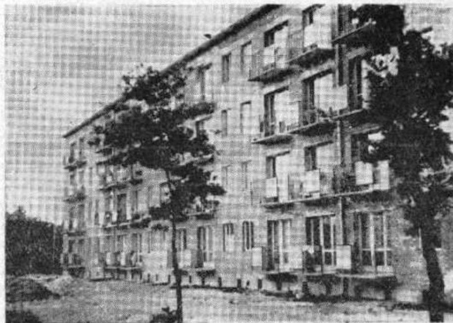
Fragment oddanego w końcu maja bloku mieszkalnego Spółdzielni Mieszkaniowej „Metalowiec”. Foto Witold Borowiec
