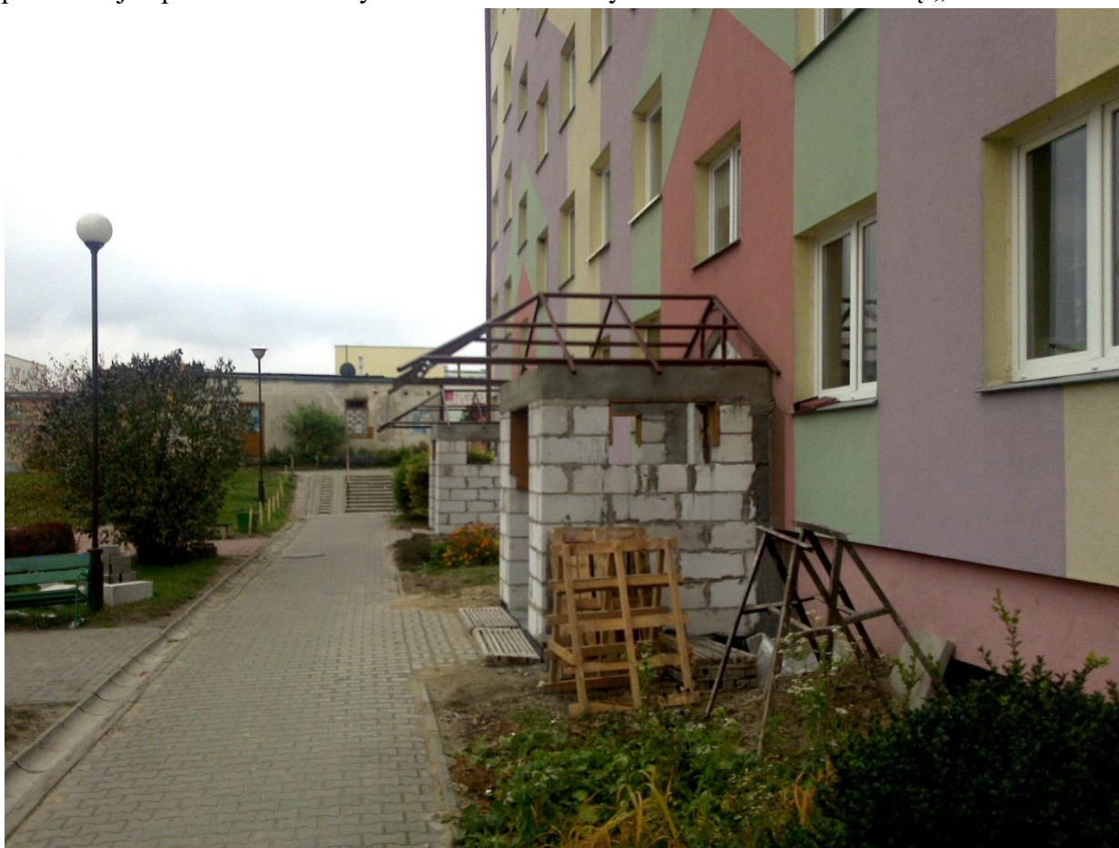
Przebudowa wejść do klatek schodowych, rok 2012
