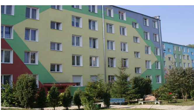
Zdj. blok przy ul. Dekutowskiego 7
